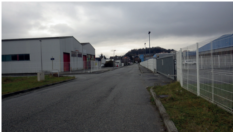
Des espaces publics plutôt routiers
