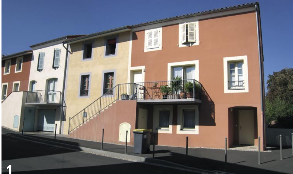
Résidence Porte d'Eau, Montferrand, 9 logements locatifs sociaux, 2003, MOE : Faget Gendre Ressouche, MOA : OPHIS.
