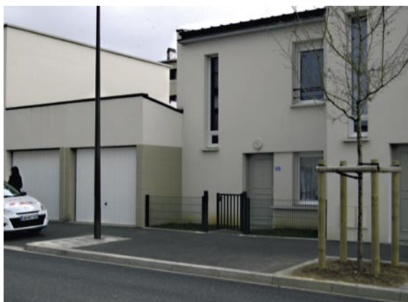
Exemple d'alignement de garages sur rue. Boulogne-sur-Mer (62).
