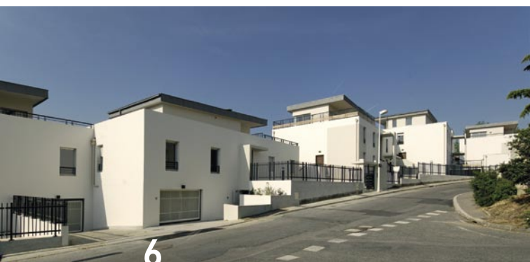
Le Coteau, Lyon 9ème arrondt. (69), 28 logements locatifs sociaux, 2006, MOE : BBC Architecte, MOA : SACVL.
