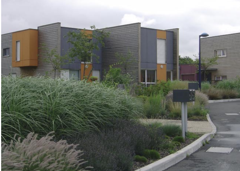
Ilot F - Les Bosquets, quartier du Petit Bétheny, Reims (51), 16 maisons, 2006, MOE : Cabinet François Lausecker, MOA : Foyer Rémois.
