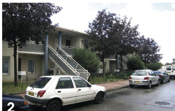
Les Forges, Saint-Fons (69), 17 logements locatifs sociaux dont 10 intermédiaires, 1993, MOE : AAMCO, MOA : OPAC du Rhône.
