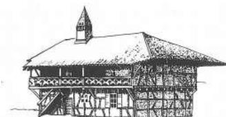
1 - Ferme bressane à étage. St-Trivier-de-Courtes. On distingue deux emplois de la terre dans cette construction : le pisé et le torchis dans les colombages (pan de bois dont les vides sont tressés de claies en branches servant de support pour le remplissage). Ferme de la Forêt, dont il ne reste qu'une moitié.
