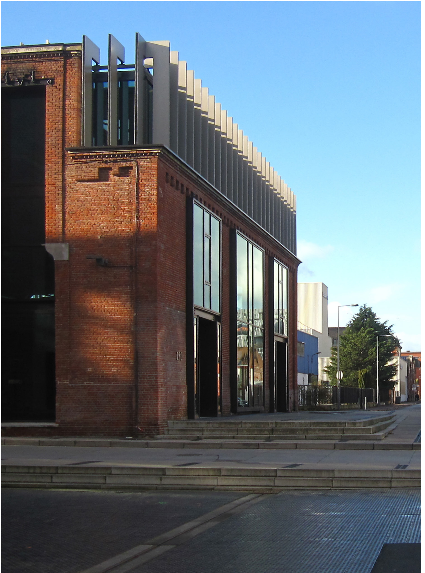
La façade Est du bâtiment Place agit comme fond de scène de la place de Bretagne où s'affiche une nouvelle figure couronnée.
