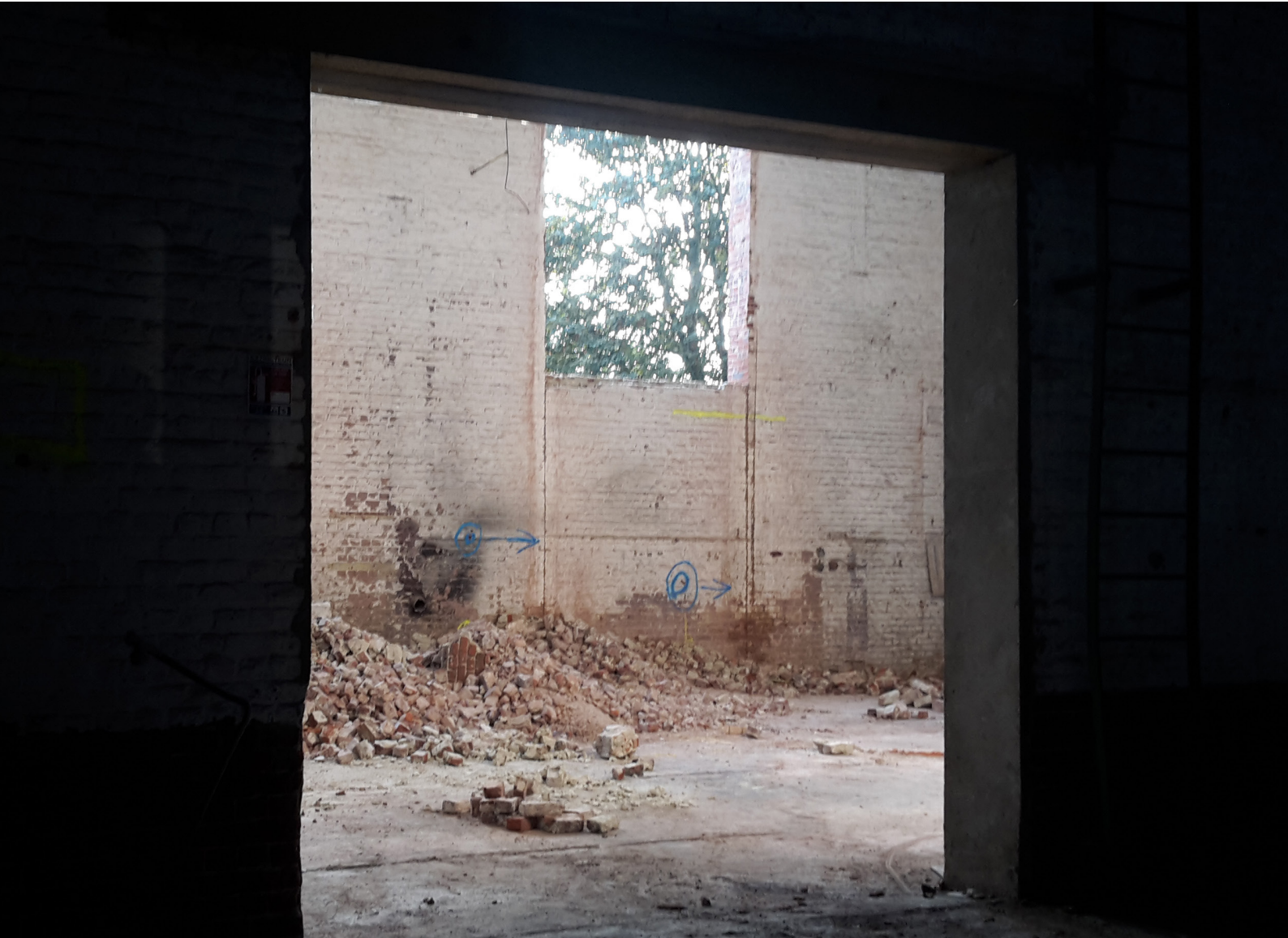
▲ Les consoles en béton préfabriqué, insérées à mi hauteur des baies, servent à chaîner la façade et à recevoir le nez du nouveau plancher intermédiaire. Les achelets s'apprêtent à recevoir la future charpente.
