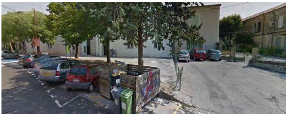
La rue des Boisseliers avant travaux : des revêtements dégradés, de nombreux obstacles et des ruptures de niveaux
