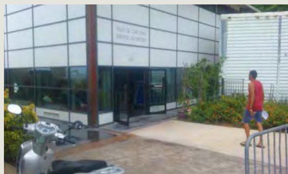
Accès à une salle de sport avec seuil à niveau
