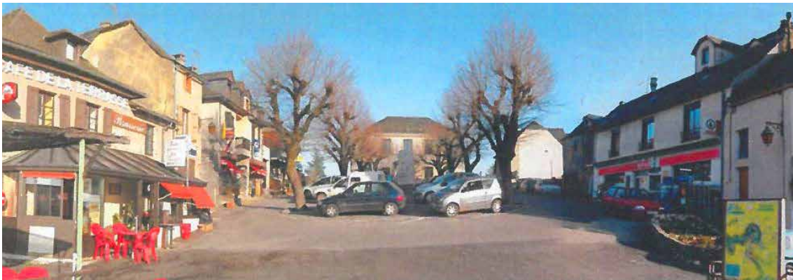
Place avant travaux. En arrière-plan derrière les voitures, la mairie. Photo prise dos au belvédère
