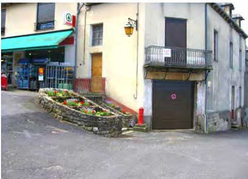
Accès à la supérette - AVANT
