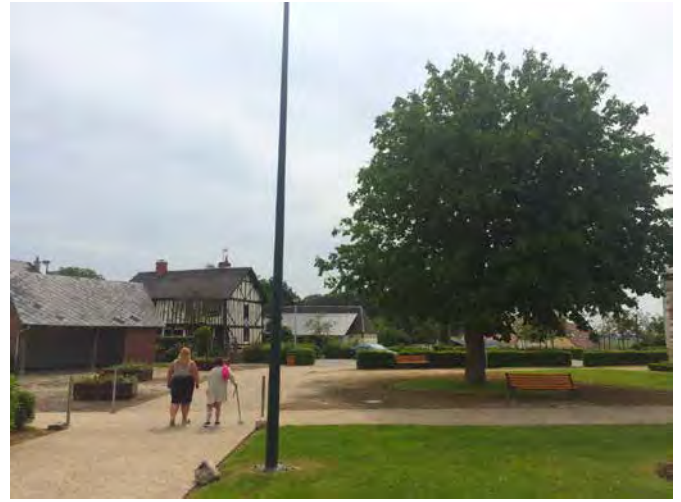
Ensemble « plateau » permettant un accès aisé à l'ensemble de l'opération
