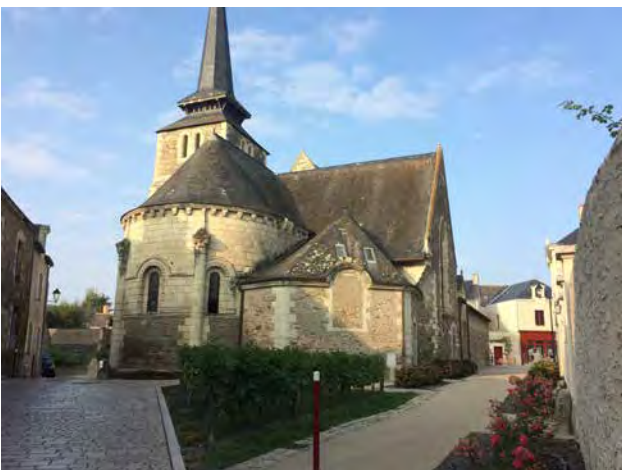
À droite de l'église, le cheminement piéton accessible À gauche, la zone 30
