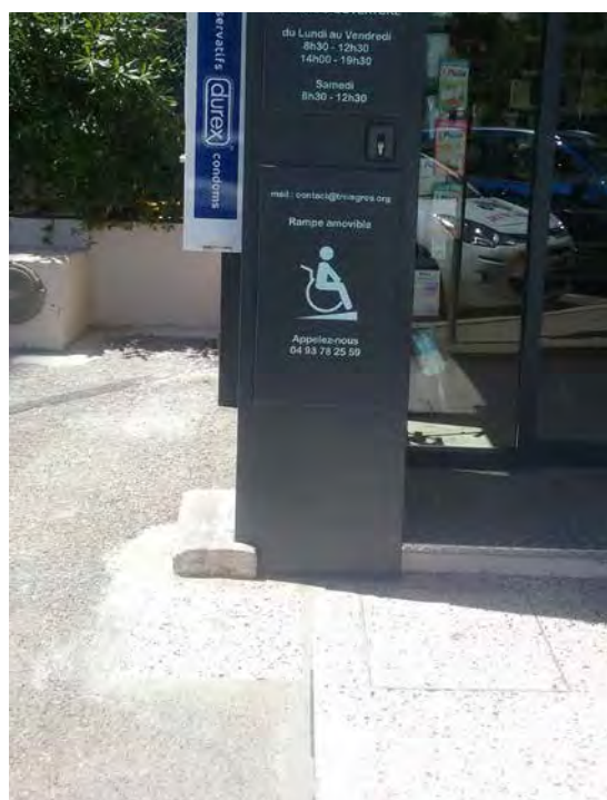
Exemples de rampes d'accès à des commerces ou de système amovible avec dispositif d'appel
