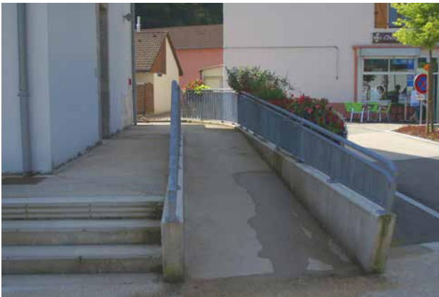
Une rampe assure l'accès à la poste et au salon de coiffure
