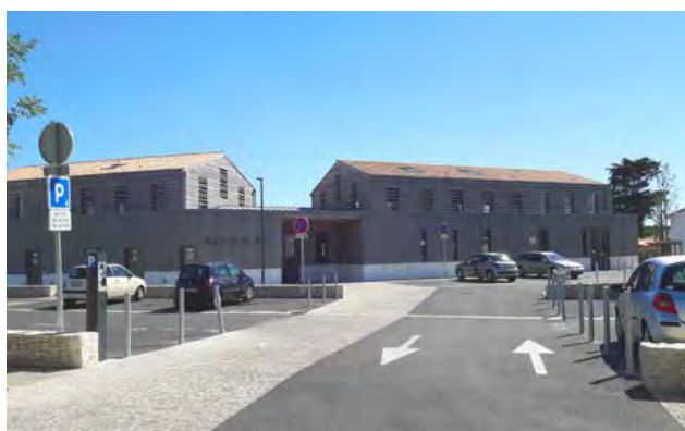
Zone de stationnement avec cheminement et places PMR.
