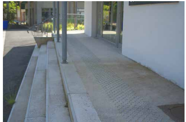
Des escaliers signalés par des bandes podotactiles
