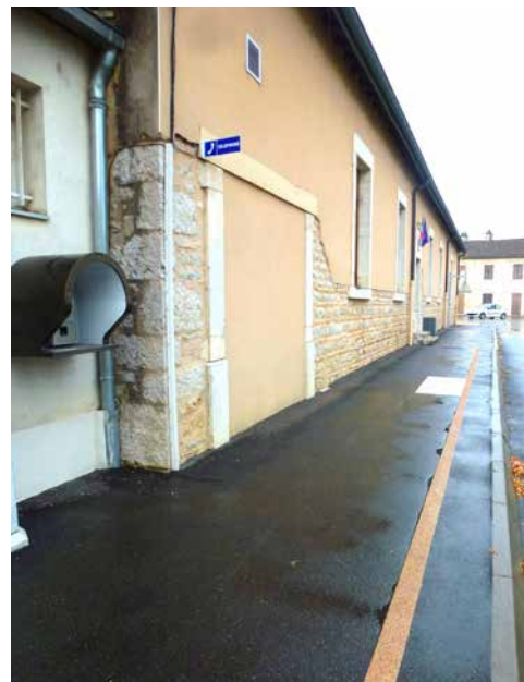
Une cabine téléphonique murale accessible a été installée à proximité de l'arrêt de bus
