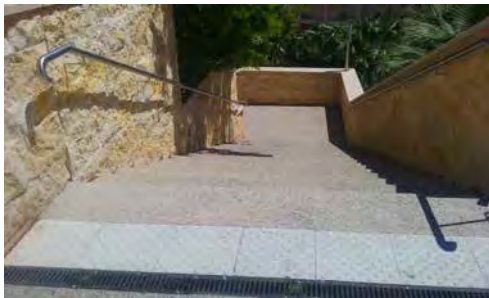
Escaliers munis de mains courantes et de BEV
