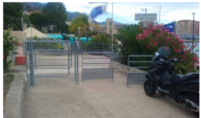
Dispositifs de sas permettant l'accès des fauteuils roulants et des poussettes
