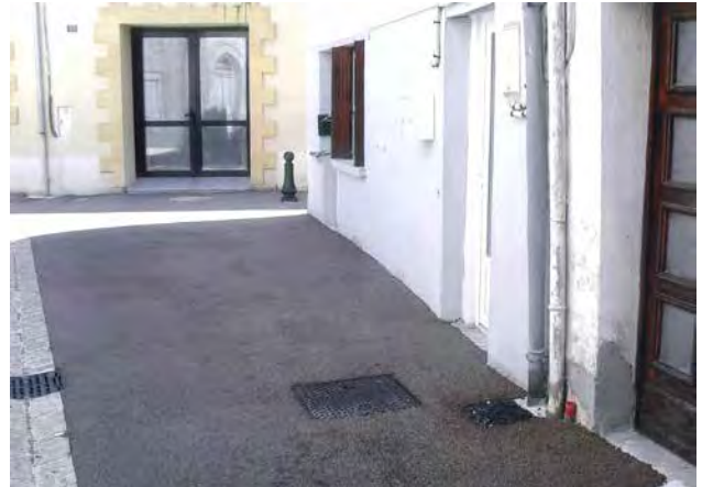
APRÈS - L'entrée se fait à présent de plain-pied. Le cheminement est plus large et comporte moins de dévers
