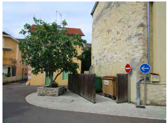
APRÈS – Démolition du bâtiment, plantation d'un arbre et installation d'un abri paysager pour les containers
