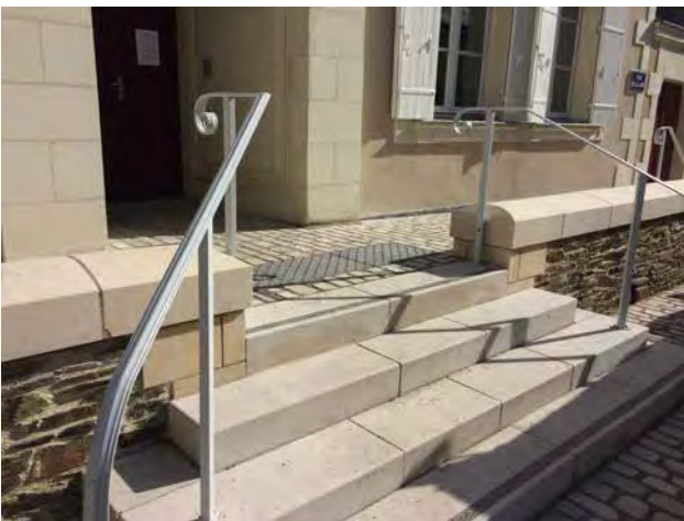
Rampe d'accès à la mairie
