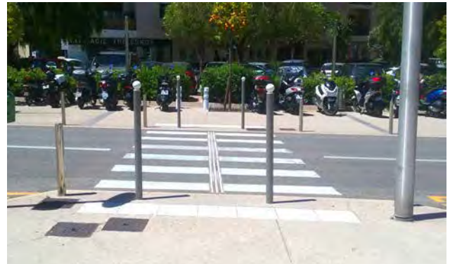
Traversée piétonne au droit de la place de la Liberté L'aménagement est satisfaisant, mais un contraste plus marqué entre la BEV et le trottoir aurait pu être obtenu en choisissant une BEV plus foncée (noire par exemple)
