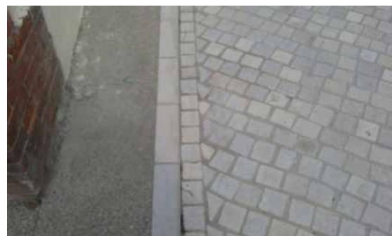
Exemples de marquage des pieds de façade par une bordure avec vue de 2 cm, servant de guide pour les PAM
