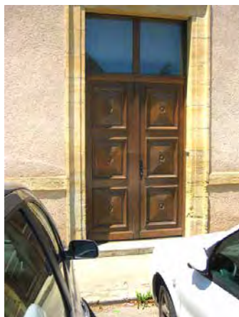
Entrée arrière de la mairie - AVANT
