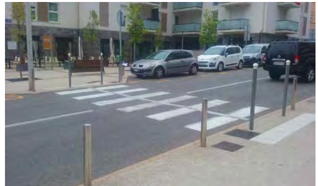
Traversée piétonne au droit de la place de la Liberté L'aménagement est satisfaisant, mais un contraste plus marqué entre la BEV et le trottoir aurait pu être obtenu en choisissant une BEV plus foncée (noire par exemple)
