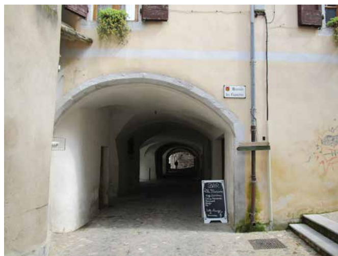
Exemple d'une rue sous arcades, après travaux
