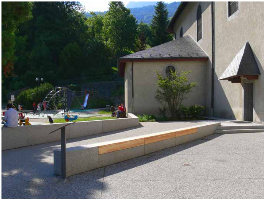
Aménagement de la placette du cadran
