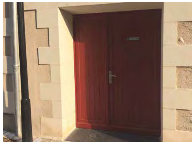
L'accès aux toilettes publiques
