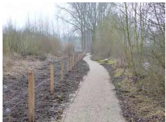
Grave compactée, ayant une faible granulométrie
