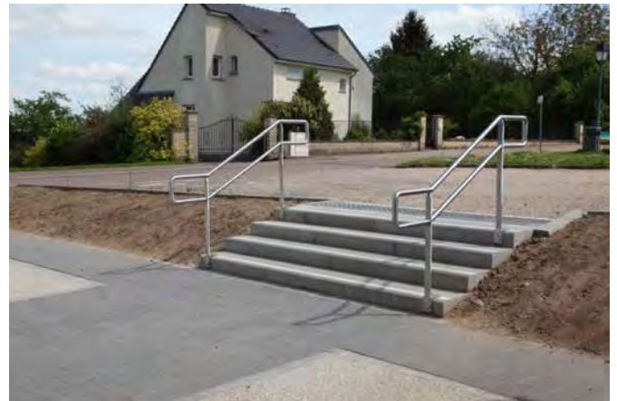
APRÈS – Main courante de part et d'autre de l'escalier et bandes contrastées sur le nez de toutes marches
