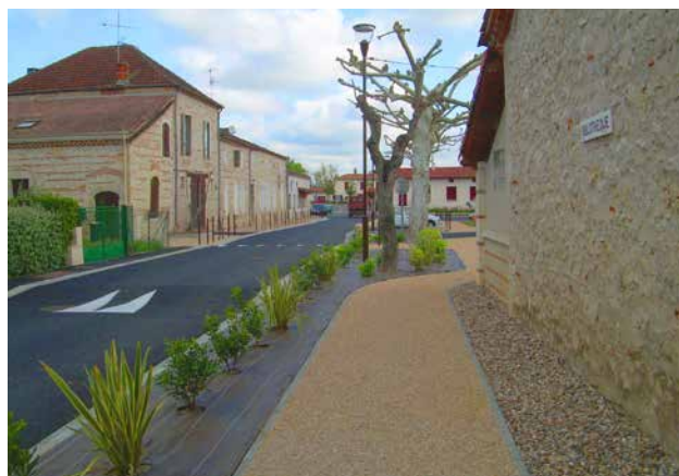
APRÈS - La voie ouest réaménagée et, en arrière-plan, le Placié
