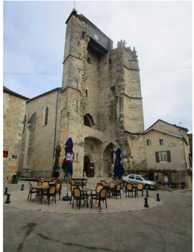
Utilisation du giratoire de la place Saint-Martin comme espace de terrasse du bar-restaurant
