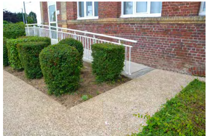
Création d'une rampe pour l'accès à la salle polyvalente
