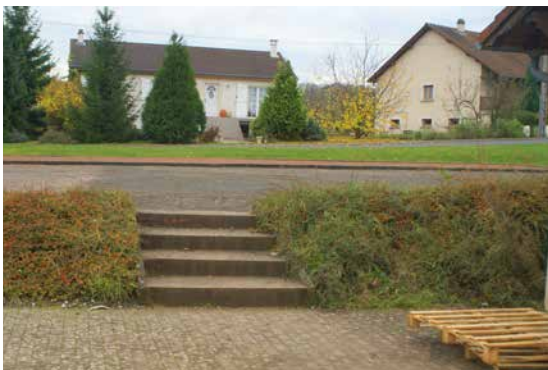
Escalier depuis le parking – AVANT
