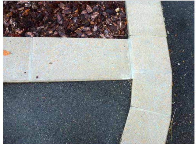
Des matériaux simples : enrobés et bordures larges
