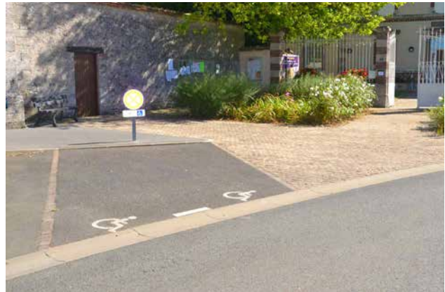
Création d'une place accessible face à l'entrée de la mairie
