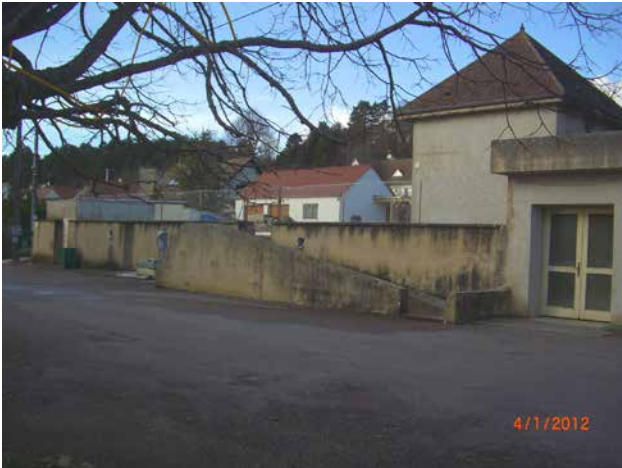
Place des Tilleuls devant l'ancien réservoir – AVANT
