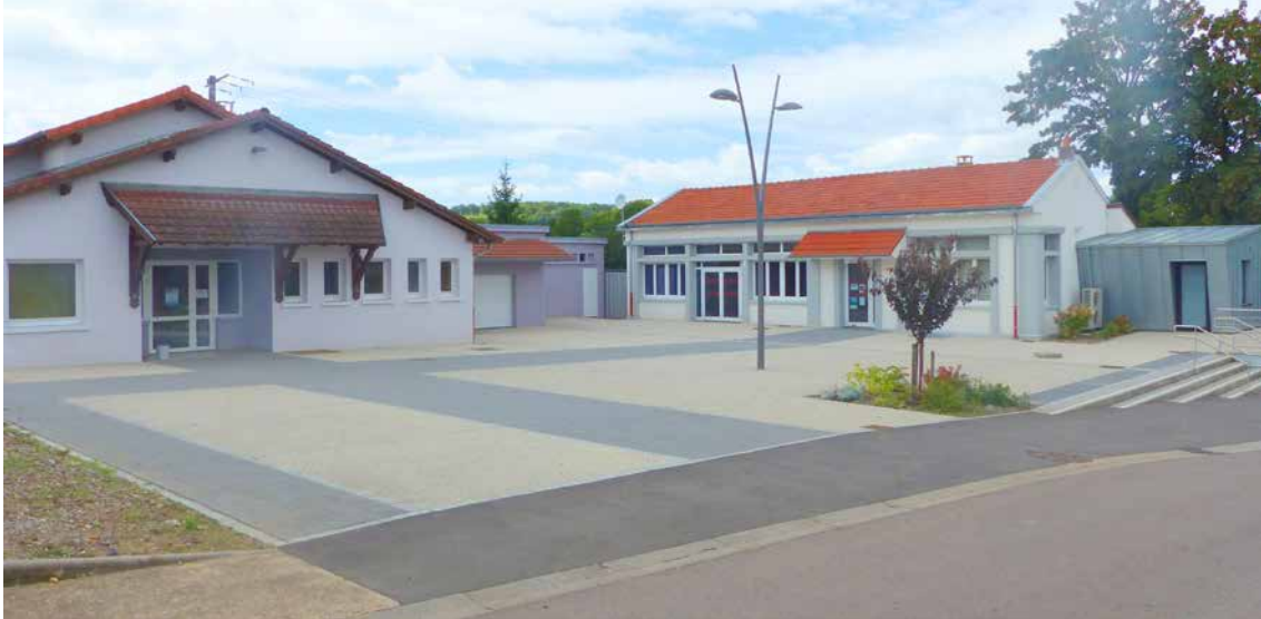
Cheminements piétons clairement identifiés et nouvel éclairage du parvis
