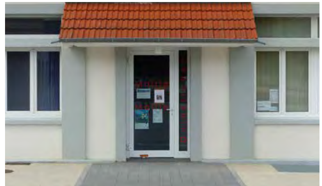
APRÈS – Nouvel accès à niveau
