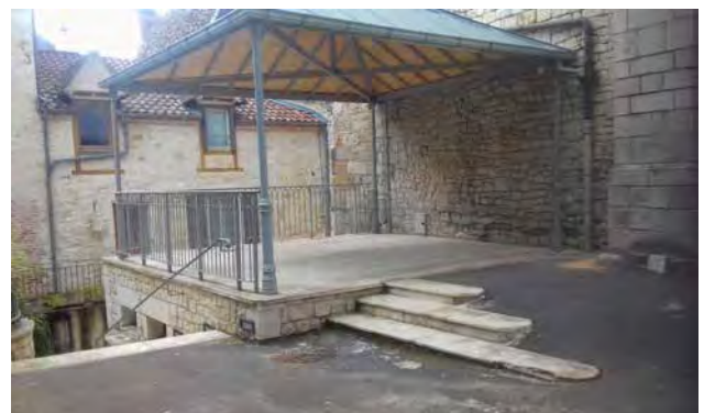
Partie supérieure du kiosque Saint-Martin: un espace ouvert tout en étant abrité
