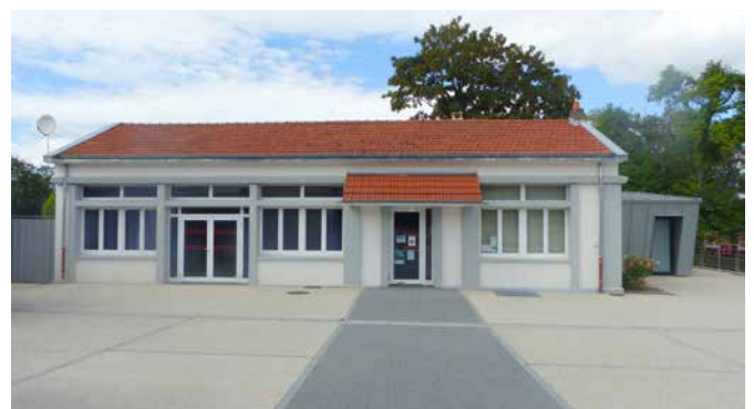
APRÈS – Pentes réglementaires et cheminement piéton accessible vers la mairie
