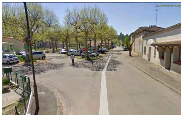
Le Placié et la voie ouest- AVANT
