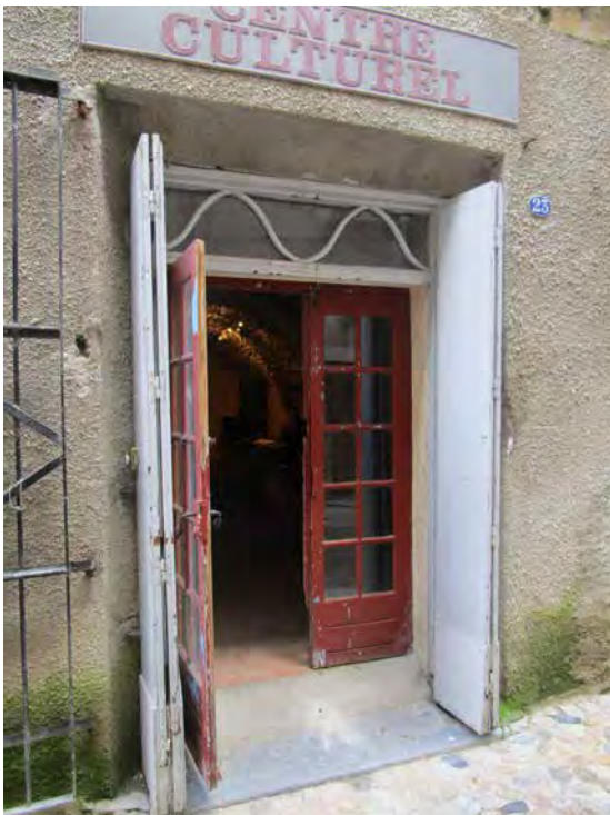
Exemples d'accès à des bâtiments (ERP) avec un ressaut franchissable
