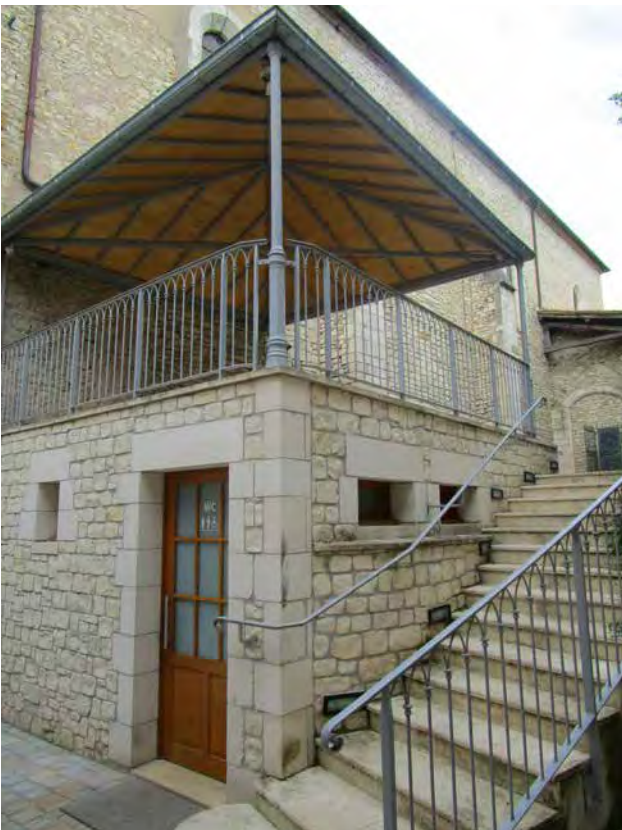
Partie inférieure du kiosque Saint-Martin: des sanitaires accessibles
