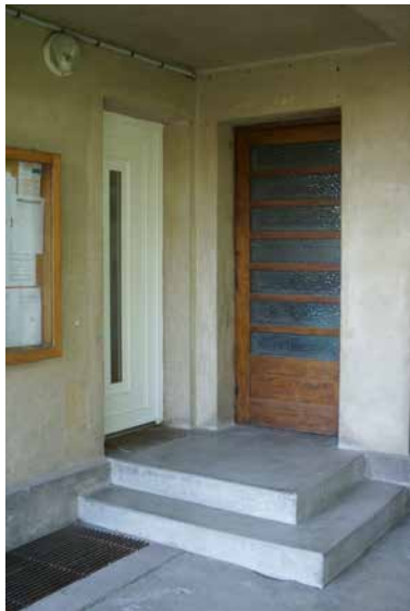
Accès à la mairie – AVANT
