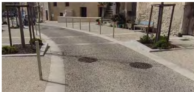
Dans la zone de rencontre, les espaces à niveau sont différenciés par les matériaux
