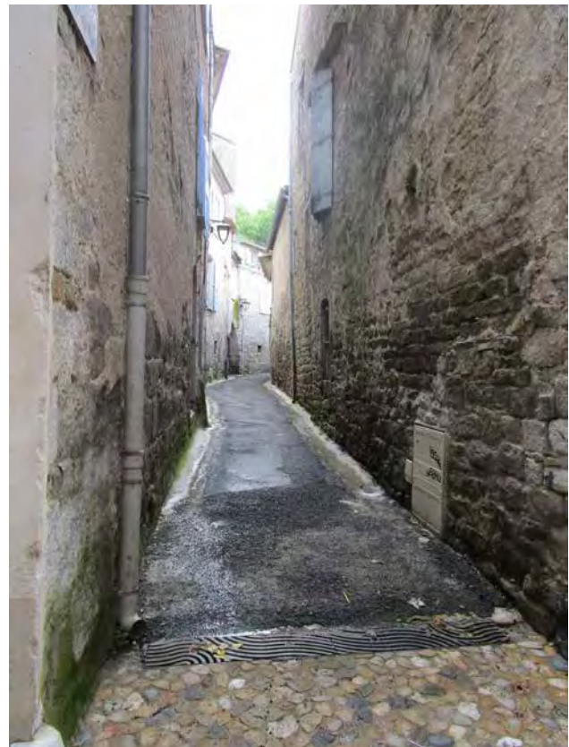
Limite entre rue réhabilitée et rue non réhabilitée
