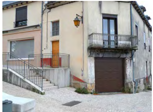
APRÈS - Accès à la supérette
