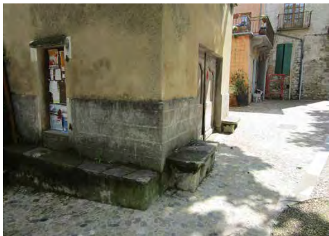
Des assises sont intégrées à la façade d'origine, rendant ainsi l'espace plus ouvert et convivial. Il n'a pas été nécessaire d'ajouter du mobilier
