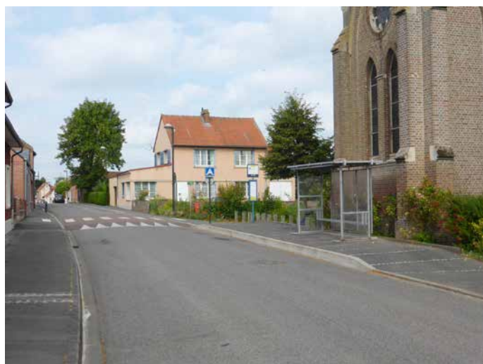
Quai bus accessible devant l'église. Un plateau permet de modérer la vitesse des véhicules motorisés
