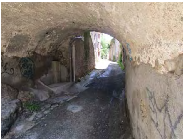
Exemple d'une ruelle avant les travaux de réhabilitation
