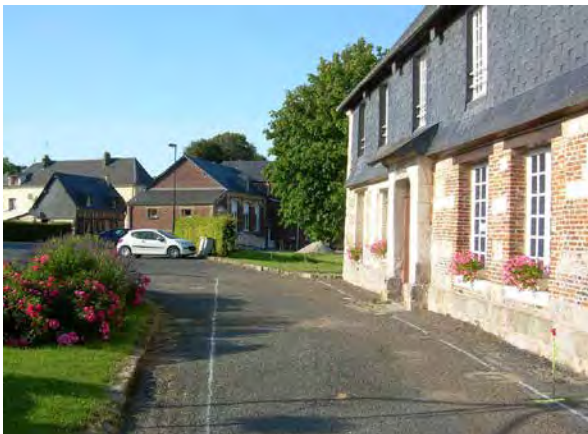
Accès à la mairie - AVANT
