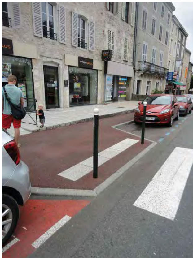
Boulevard Louis-Jean Malvy après travaux : organisation de poches de stationnement et aménagement de traversées accessibles
