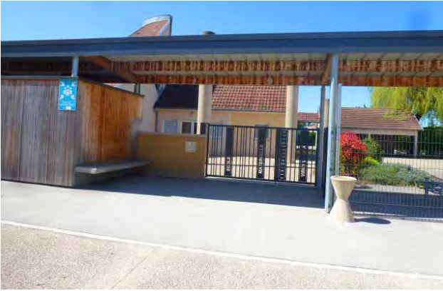
Entrée unique des écoles, dotée d'un banc et abritée par un auvent
