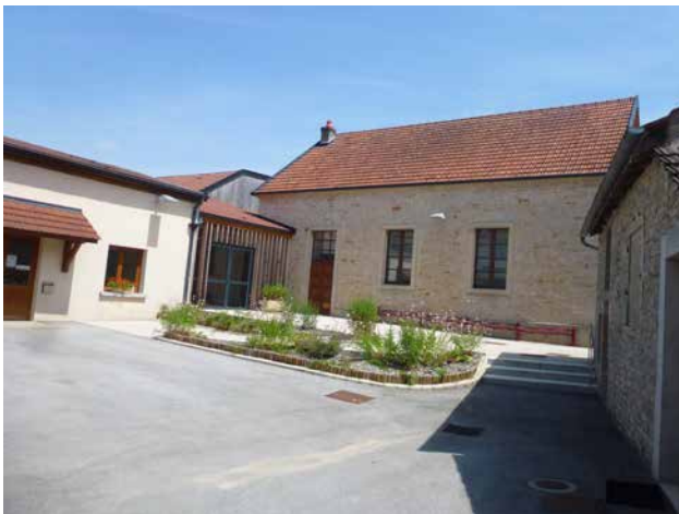
Entrée de la salle municipale intégrée dans la rampe de la venelle
