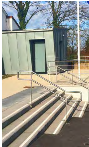
Autre escalier avec main courante, bandes podotactiles, nez de marche contrastés
