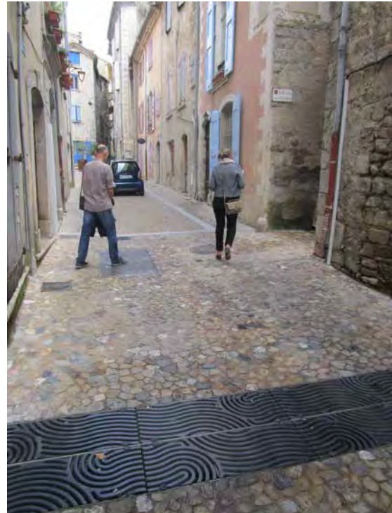
Exemple de rue après travaux: certains seuils persistent, mais les conditions de déplacement et d'accessibilité ont été globalement améliorées
