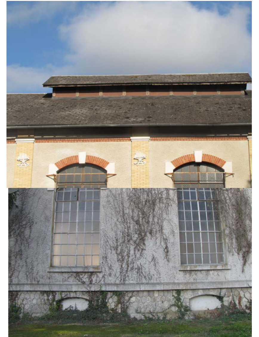
Détails des baies
