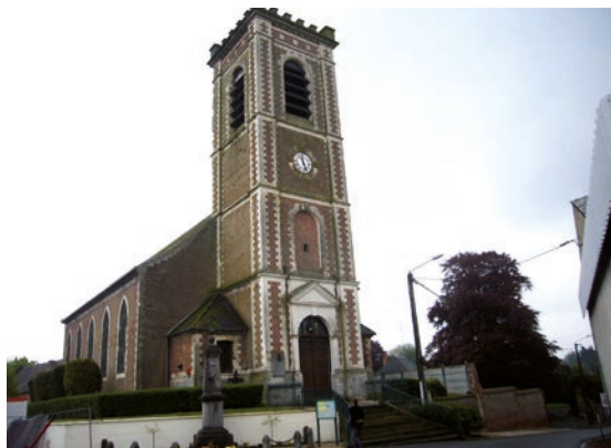
●● L'église de Jenlain, modifiée par l'architecte Fiévet
