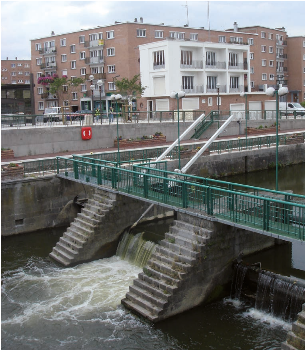
●● Vannes de contrôle de niveau et de débit sur la Sambre à Maubeuge
