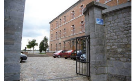
●● Casernes d'Avesnes, réhabilitées en logements
