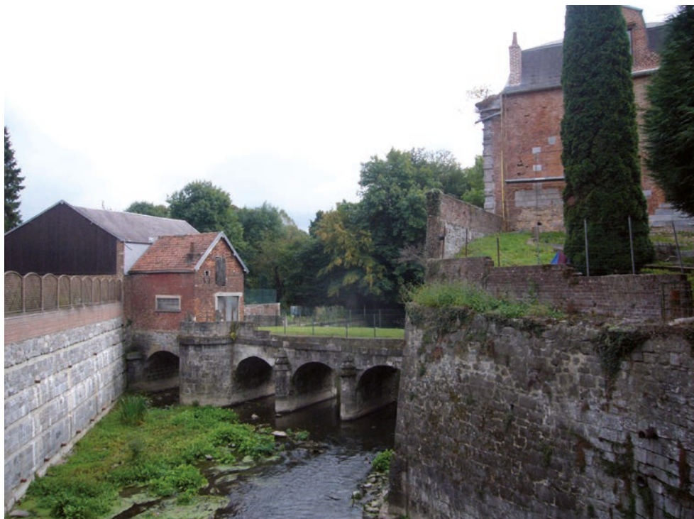
●● Pont à Avesnes-sur-Helpe
