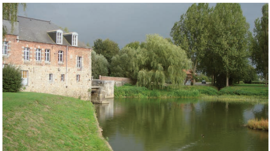
● Étang à l'aval du moulin, sur le cours de l'Helpe Mineure à Maroilles
