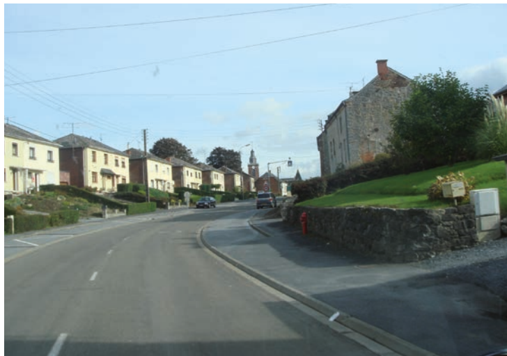
●● Habitat ouvrier à Trélon
