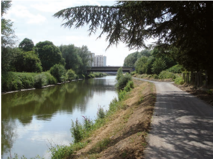
● ● Vue vers l'amont de la Sambre, depuis la station d'épuration de Maubeuge
