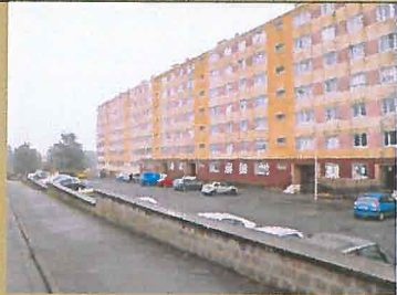
Résidence Jeanne III (82 logements)
