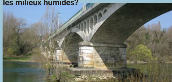
Franchissement routier à Pont d'Ain
