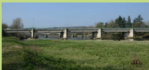
Franchissement routier et ferroviaire à Pont d'Ain
