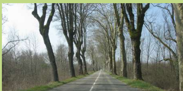
Alignements de platanes valorisant le réseau routier
