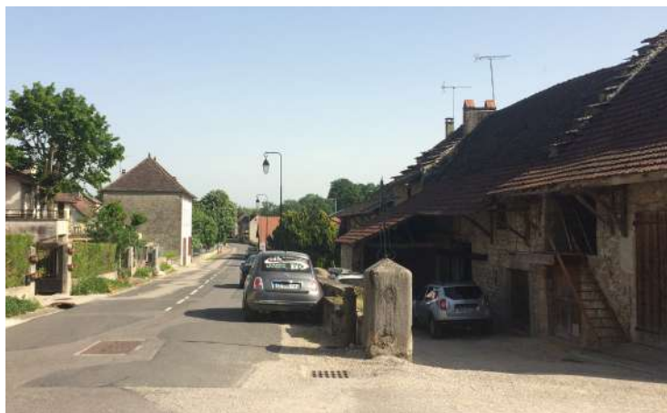
1- Le bâtiment rural traditionnel En bande en alignement sur rue.
