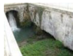
Pont-canal, XIXe Noyelles-sur-Escaut
