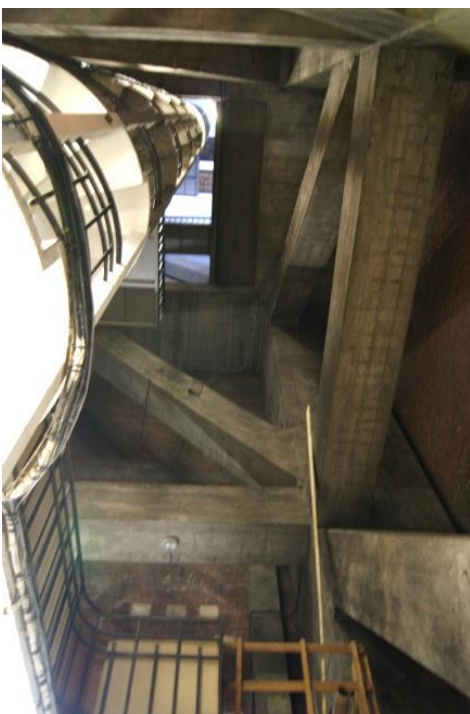
Le beffroi d'Arras, la structure intérieure (CF-22 août 2013-)
