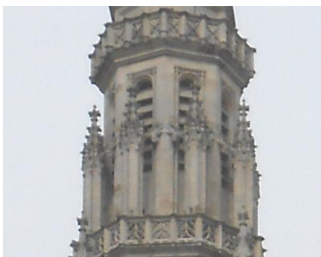
Place des Héros, 2 ème niveau du beffroi
