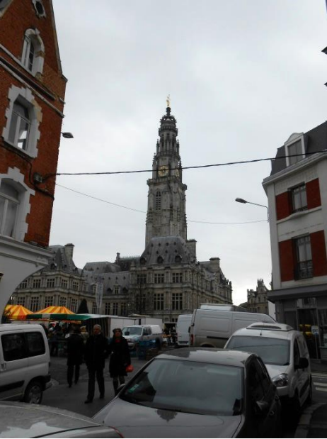
7 : Rue Ernest De Lannoy, vue du beffroi
