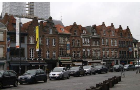
Grand-Place, façades sud (CF-18 novembre 2013-)
