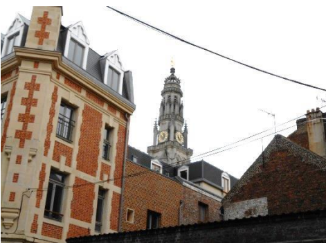
6 : Rue des Grands Vieziers, vue du beffroi
