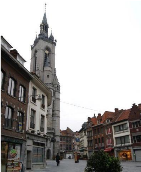
4 : Rue des Chapeliers, vue partielle du beffroi
