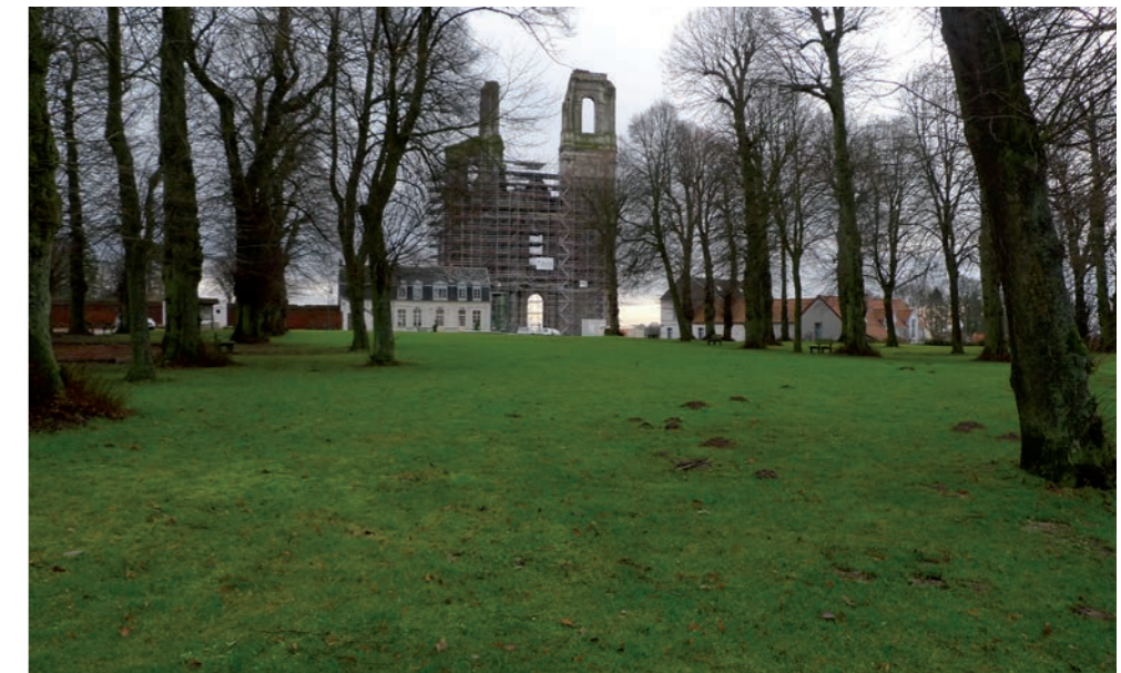
Eglise du Mont Saint Eloi partiellement détruite pendant la guerre. Lieu stratégique des Français, de part son altimétrie
