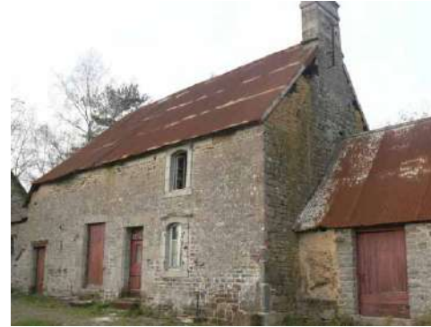
Batisse en pierre avec un toit en tôle rouillée
