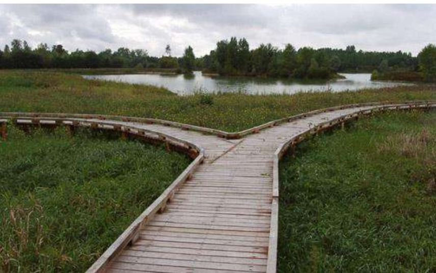
Exemple de réalisation de platelage bois
