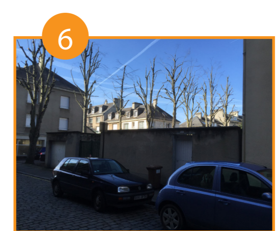
6 Place de la voiture et des garages trop importante
