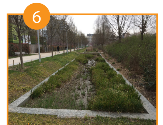
Noue au parc Martin Luther King à Paris
