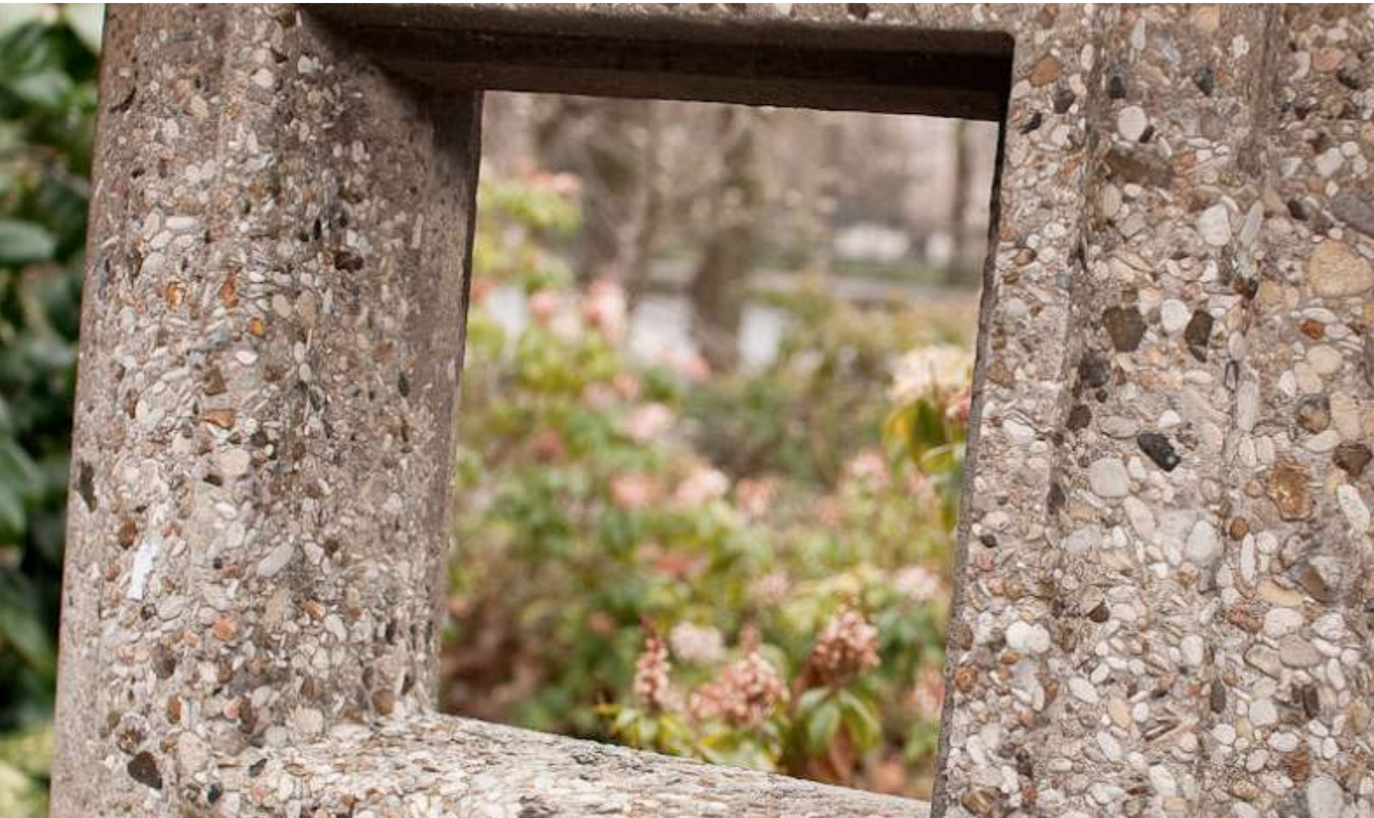
Clastra, clôture du Square Saint Roch, Le Havre
