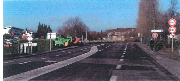
Sur-dimensionnement de la voirie aux carrefours.
