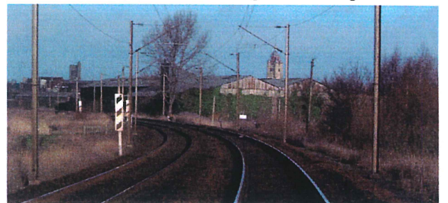
Vue tangente 1 depuis la voie ferrée (TER et TGV)
