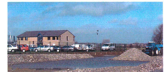
Imperméabilisation des sols (ZAC Croix Rouge).
