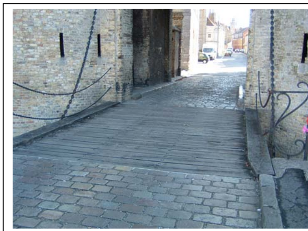
Ancien pont-levis marqué par une surface en bois Passage de la porte en pavés
