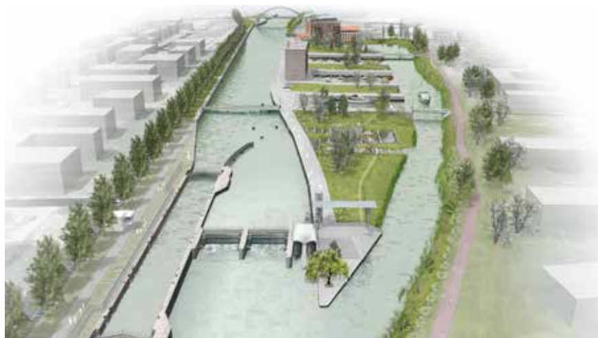
Harelbeke: projet d'écluse avec passe à poisson / ontwerp voor een sluis met vistrap
