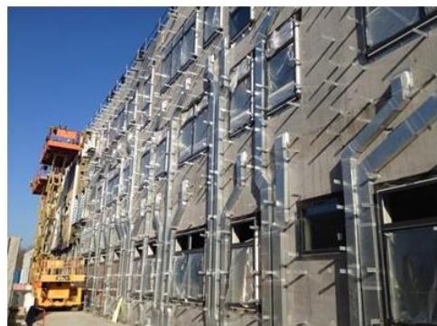
Des gaines de températion d'air neuf des puits thermiques, pièces par pièces, dans l'épaisseur de l'isolation thermique extérieure ITE
