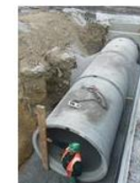
Récupération des calories sur l'air vicié par puits aéro thermique
