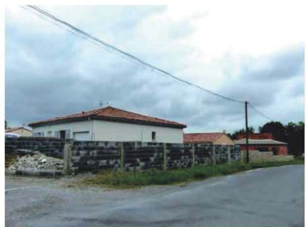
Figure 34 : Plus loin sur la route de Saint-Pierre, un lotissement se construit
