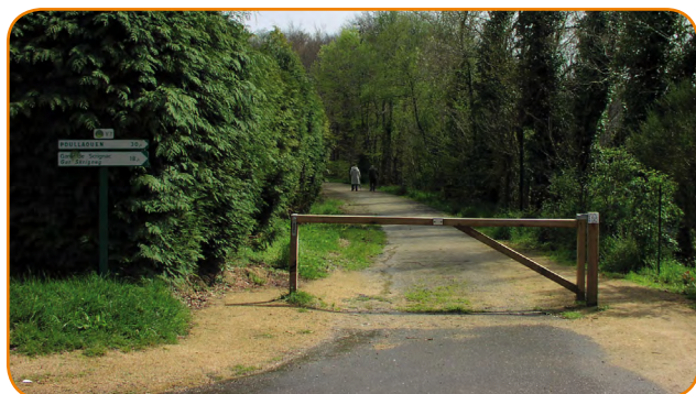
Barrières de restriction d'accès sur l'EV1 dans le Finistère
