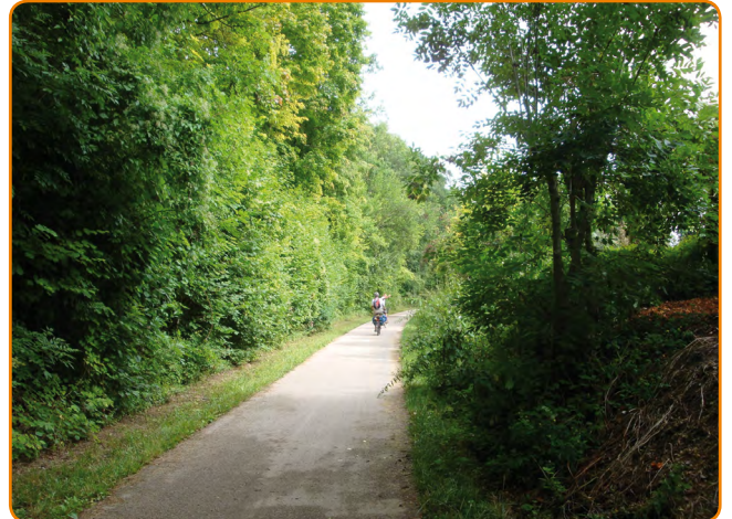
Voie verte de la vallée de l'Epte, réalisée sur une ancienne voie ferrée en fond de vallée : choix d'un enrobé clair coulé à froid. Très roulant, faible entretien et bonne intégration paysagère.
