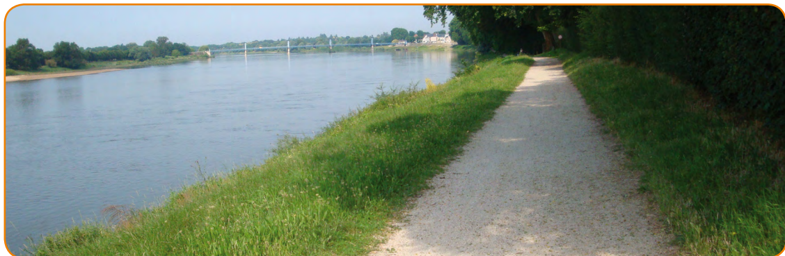
Largeur modeste et revêtement poreux sur la Loire à Vélo
