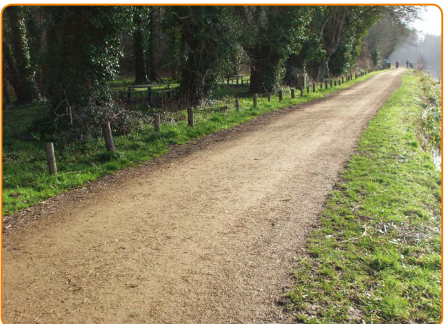
Niort : voie cyclable réalisée le long de la Sèvre niortaise en sable stabilisé à liant pouzzolanique, lui conférant un aspect de chemin de terre et une bonne roulabilité.
