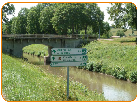
Panneau de signalisation directionnelle sur le canal du Nivernais, implanté à une hauteur de 1 mètre environ.
