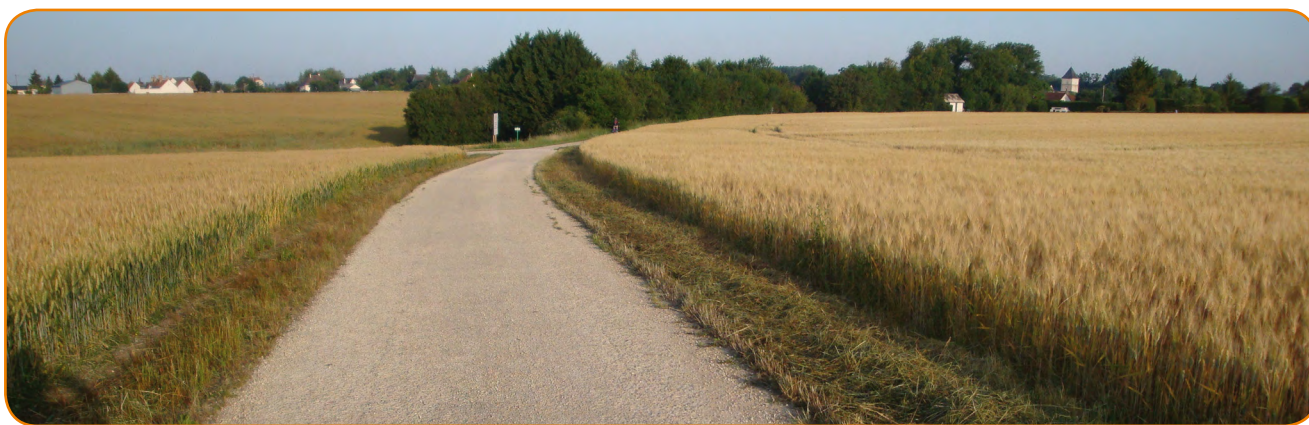
Revêtement calcaire compacté. Campagne agricole près de Chambord.
