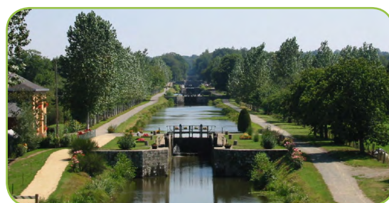
Échelle d'écluses de Hédé
