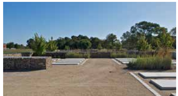
Alcôve en murs de gabions au nouveau cimetière de Beausoleil-les-Sorinières (44) © Atelier architecture Philippe Madec
