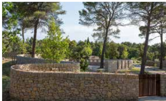
Mur d'enceinte en pierres naturelles de l'extension paysagée du cimetière de Saint-Marc-Jaumegarde (13). Equipe Frédéric Gimmig, David Mossé, Reliefs Paysagistes
