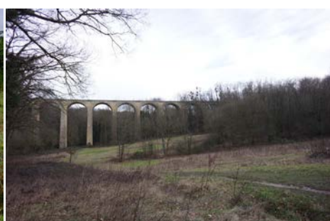
Viaduc des Fauvettes
