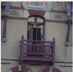
Fenêtre et balcon en bois.
