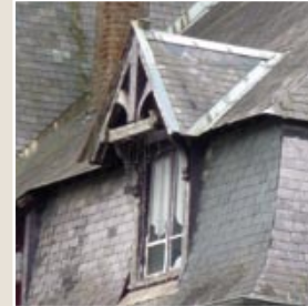
Lucarne jacobine. Sa toiture a 2 pans.
