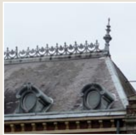
Epi et crête de faîtage et lucarnes « œil de bœuf ».
