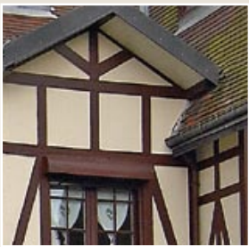
Enduit ciment. Il imite le colombage en bois ou la pierre.
