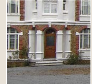
Perron et porte d'entrée principale.
