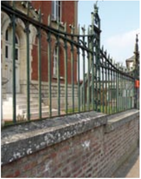
Clôture mur « bahut » surmonté d'une grille en ferronnerie.
