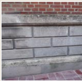
Enduit ciment. Il imite le colombage en bois ou la pierre.
