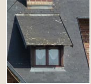
Lucarne rampante dite « chien couché ».
