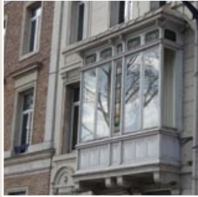
Bow-window. Extension en bois et verre en applique sur la façade.
