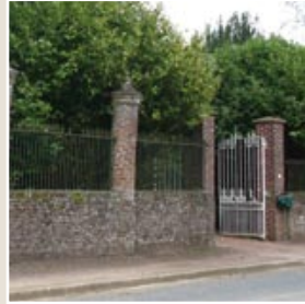
Clôture et portail. Mur « bahut » surmonté d'une grille en ferronnerie
