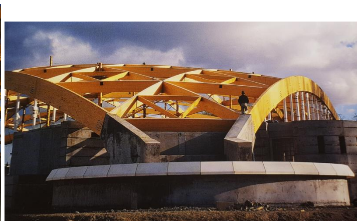
Fig. 3, 4, 5 et 6 – Photos de chantier. Montage de la structure en bois lamellé-collé, reposant sur culées en béton armé. © ORLANDINI Alain, « Ensemble nautique de Nogent-sur-Oise/Villers-Saint-Paul (Nogent-sur-Oise), 1995 », dans Roger Taillibert, réalisations , tome 2, Paris, Somogy Editions d'Art, 2006, p.142-149. / Repro : L. Schlosser.
