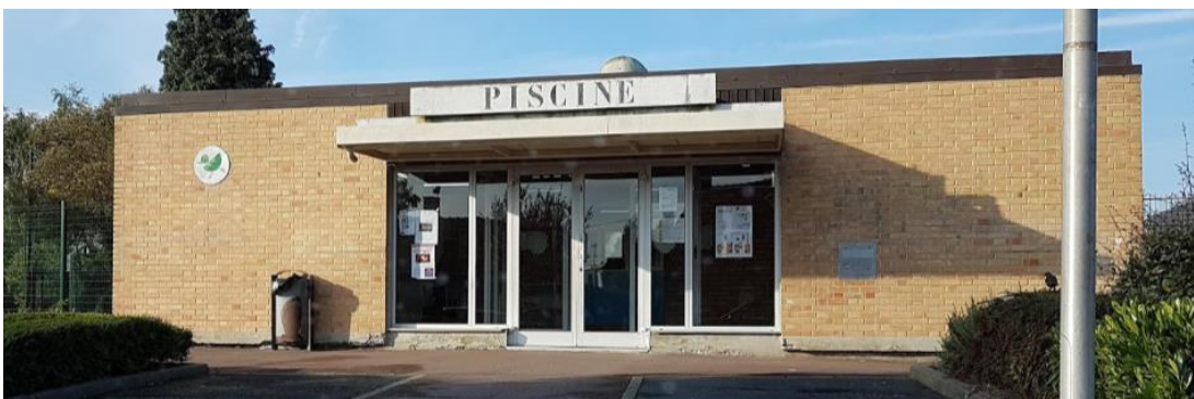
Fig. 18 – Entrée piscine caneton de Somain (Nord), inaugurée en 1976. © Cliché : Arnaud Batteau octobre 2016.
