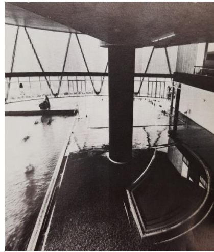
Fig. 9 – Piscine de Liancourt, vue des bassins, position fermée, vers 1972. © AN ; 19840036/119. Fig. 10 – Vue de la pataugeoire. © GAILLARD Marc, Architectures des sports : 107 réalisations et projets exemplaires , Paris, éditions du Moniteur, 1981, 213, p.37. Repro : L. Schlosser.
