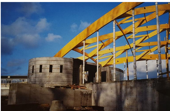
Fig. 3, 4, 5 et 6 – Photos de chantier. Montage de la structure en bois lamellé-collé, reposant sur culées en béton armé. © ORLANDINI Alain, « Ensemble nautique de Nogent-sur-Oise/Villers-Saint-Paul (Nogent-sur-Oise), 1995 », dans Roger Taillibert, réalisations , tome 2, Paris, Somogy Editions d'Art, 2006, p.142-149. / Repro : L. Schlosser.
