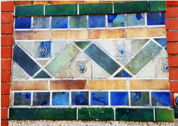
Fig. 9 – Détail de la frise décorative de la façade en briques glaçurées. © Cliché : Laurence Schlosser, 2017.
