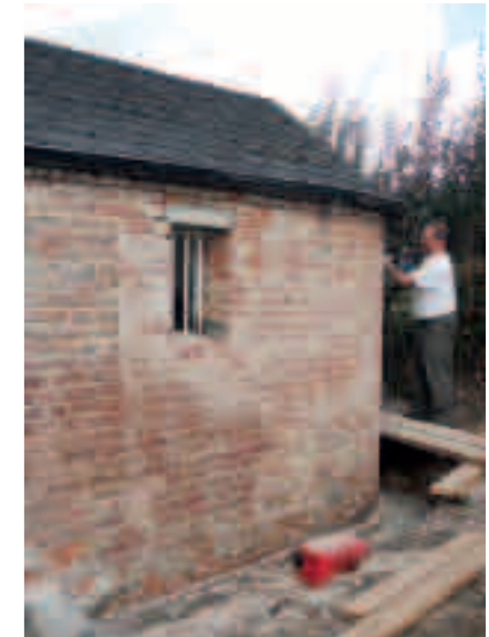
préparation du support avant enduisage
