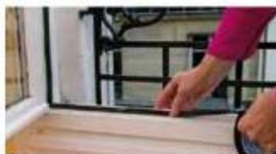
Des joints simples pour améliorer l'étanchéité à l'air : installation de joints d'étanchéité en périphérie de l'ouvrant et entre l'ouvrant et le dormant
