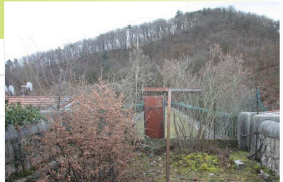
Etat du viaduc du Pertuiset avant travaux - Source FRAPNA
