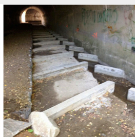
Secteur 4 Passage inférieur de l'A72 : Reconstitution du fond de lit du Bozançon
