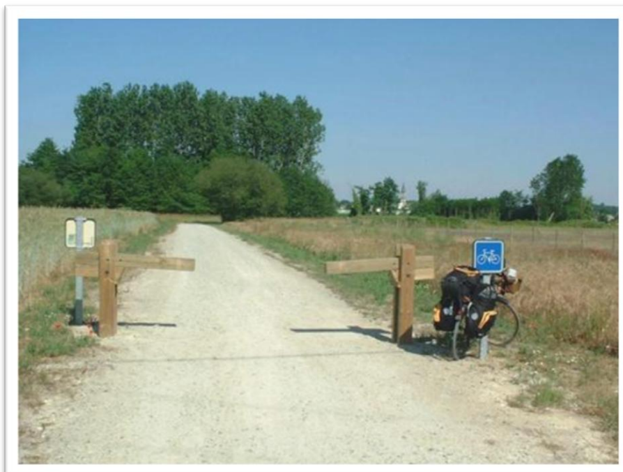
Photo : la Loire à vélo – voie en grave compactée calcaire
