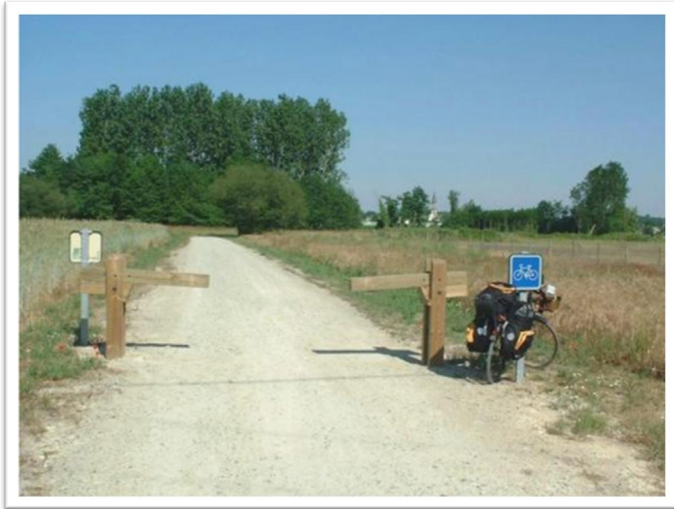
Photo : la Loire à vélo – voie en grave compacté calcaire
