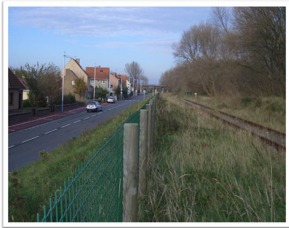
Photo de la clôture existante entre la voie ferrée et la RD60
