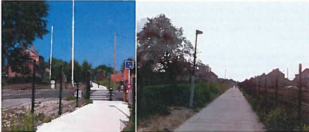
Exemple de clôture mise en place sur Dunkerque/ Rosendaël (galvanisée, noire, 2m de haut) Extrait du dossier de septembre 2015 - types de clôture utilisés
