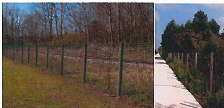
A gauche : clôture existante le long de la voie ferrée à Bray Dunes ;
