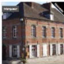
Ancien presbytère, Epe-Sauvage (31)
