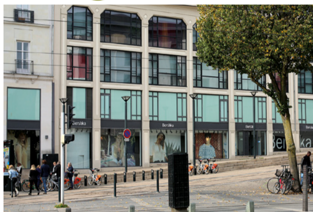
Rue de la Boucherie à Nantes, quand le patrimoine est moteur de qualité - La transformation de cette ancienne construction Art Déco en commerces et en logements a permis d'économiser l'énergie grise de son ossature en béton armé, et entraîné la création de séjours atypiques à larges baies vitrées.
