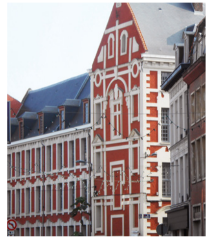
L'ancien Hôtel du Lombard à Lille. Construit en 1621, il a été réhabilité et transformé en 29 logements sociaux certifiés BBC Rénovation. Isolation intérieure, consommation inférieure à 58 kWh/m 2 /an. G.O-Architectes à Roubaix pour ICF Habitat Nord-Est. Projet participant au concours Green Building Solutions Awards 2015.
