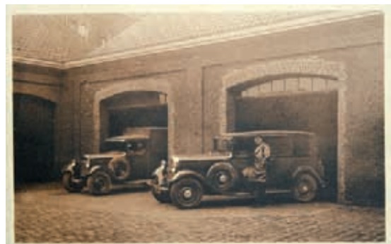
Vue du garage dans les années 1930.
