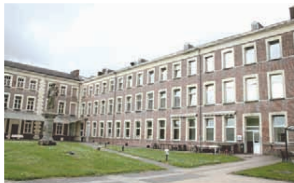
Façade du "SAAS", unité du DPR devenu en 2012 PATIO (Pôle d'Accueil Thérapeutique d'Insersectoriel et d'Orientation) sur le site de Lommelet.
