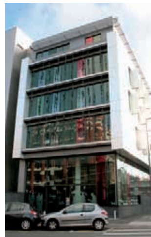
— Vue du Centre Psychiatrique d'Accueil et d'Admissions (CPAA) inauguré en février 2011 à Lille.
