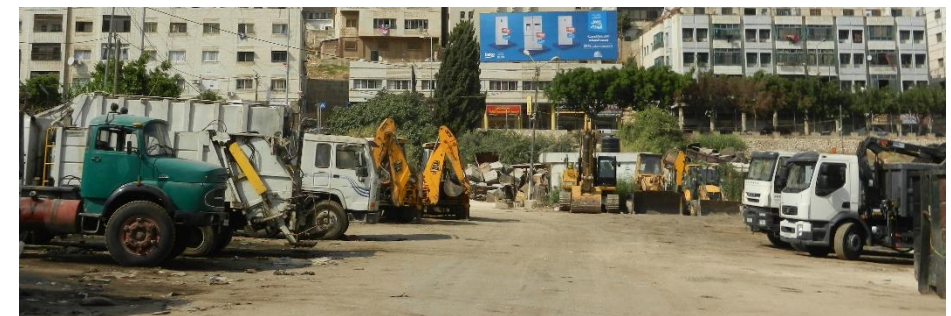
Figure 39 : le Childhood hapiness park et le parking des engins de chantier, l'un va rester, pas l'autre. - source : E.Bergery 2017
