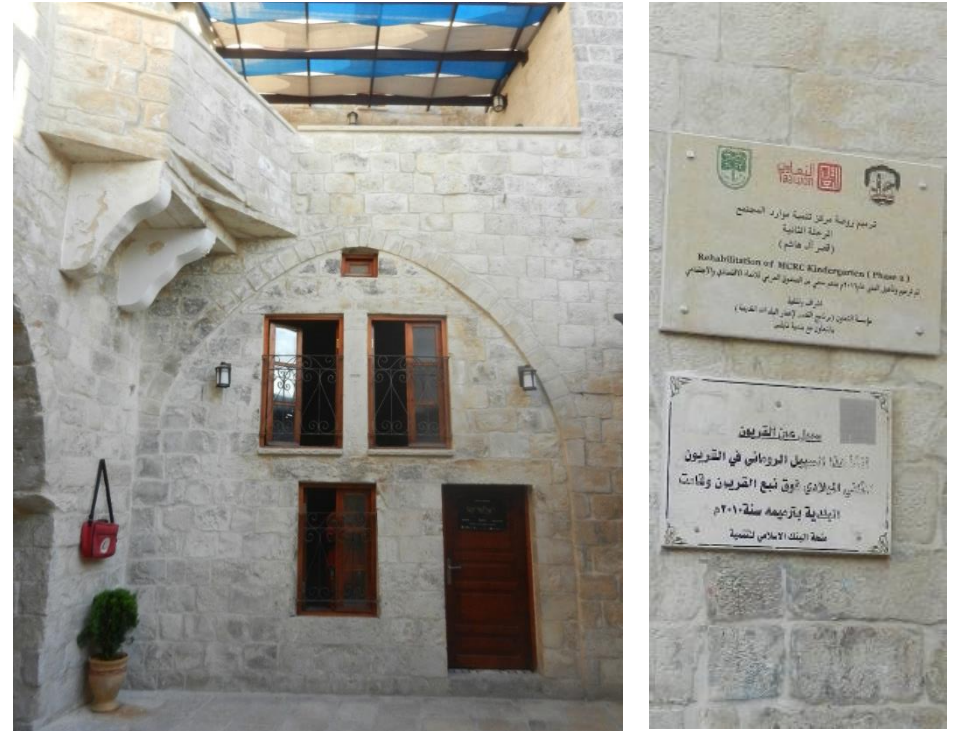
Figure 11 : Hashem Palace (MCRC) après une récente restauration par la Welfare Association – source : E. Bergery, 2017
