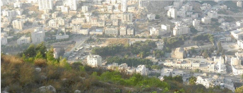
Figure 16 : Site du projet "Nablus Boulevard" dans le fond de la vallée - source : E. Bergery 2017
