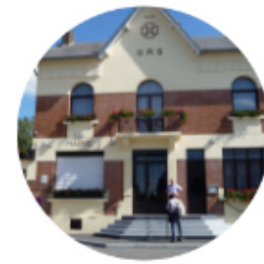
Restauration de la mairie
