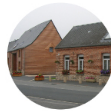
Réhabilitation d'une ferme en logements locatifs
