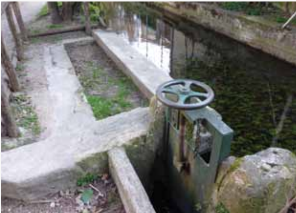
Ouvrage hydraulique, canal des Malcontents nord
