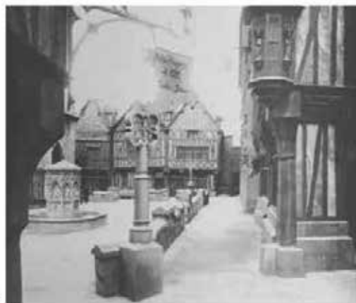
1- Presbytère de Saint-Maclou, rue Duthuit (L. Lefort architecte)
