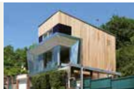
Maison “BBC ossature bois” Emmanuel Côme, architecte
