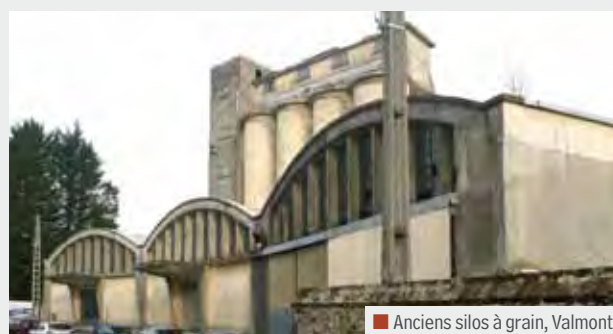
■ Anciens silos à grain, Valmont
