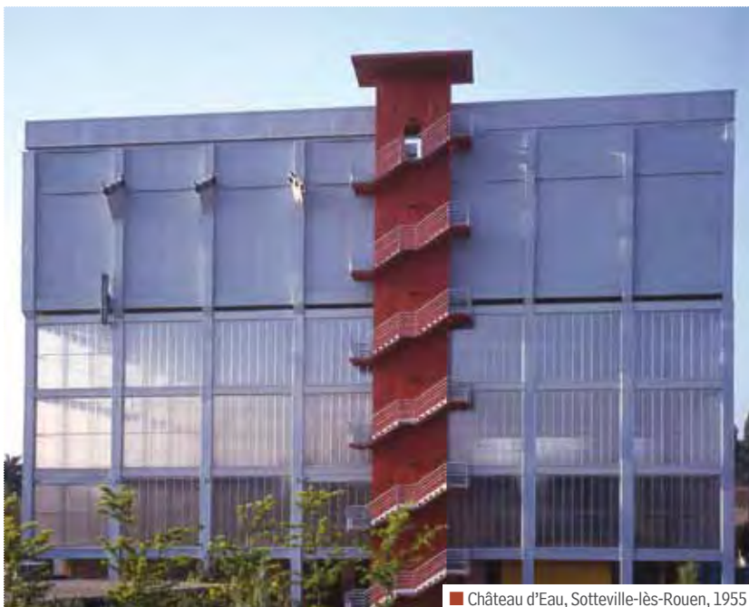
■ Château d'Eau, Sotheville-lès-Rouen, 1955
