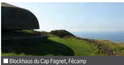
■ Blockhaus du Cap Fagnet, Fécamp
