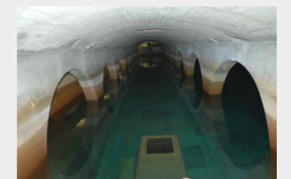
LES RÉSERVOIRS DE MONTMAUR
