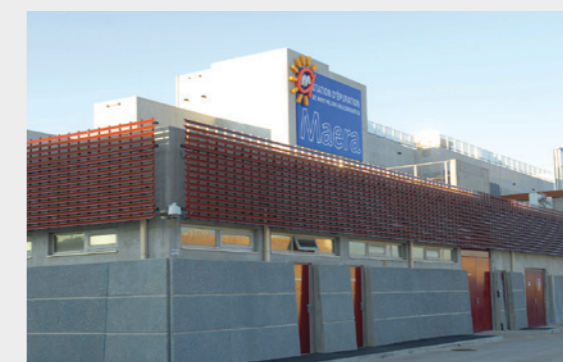
LA STATION D'ÉPURATION MAERA
