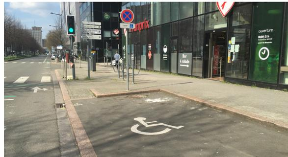
le trottoir, la largeur de l'emplacement prévu pour le véhicule peut être réduite à 2,00 m, à condition de ménager une largeur de trottoir de 1,80 m comprenant une bande latérale matérialisée de 0,80 m au droit de cet emplacement ;
