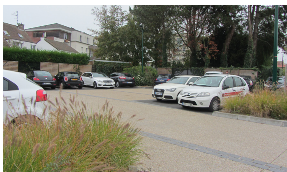
Photo 4 - Exemple de revêtement
