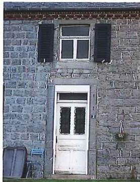
Une ferme comportant un étage : une maçonnerie en pierre à laquelle s'ajoute une corniche en brique.
