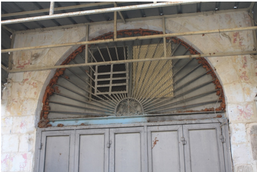
Fig.39 Exemple de fenêtre de savonnerie. Source : Atelier Lille-Naplouse 2017
