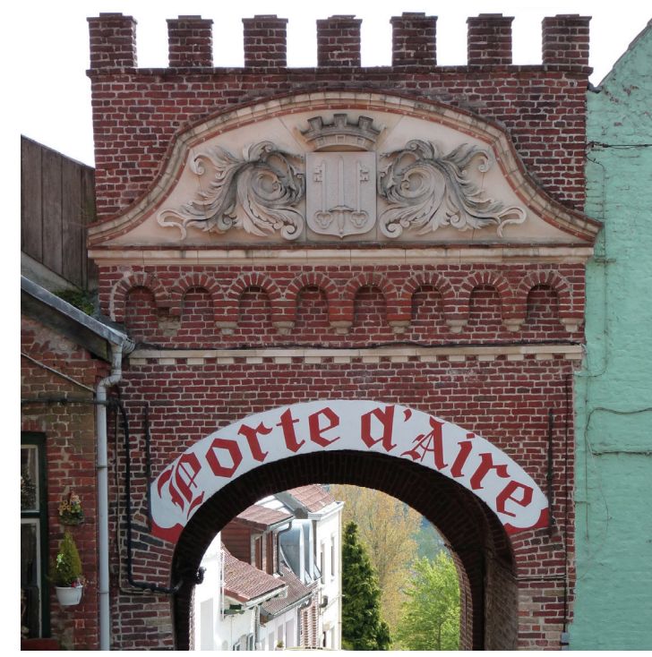
5 La porte d'Aire, située sur le flanc sud du Mont Cassel, est une des quatre portes de l'enceinte médiévale qui subsiste encore aujourd'hui dans la ville.
